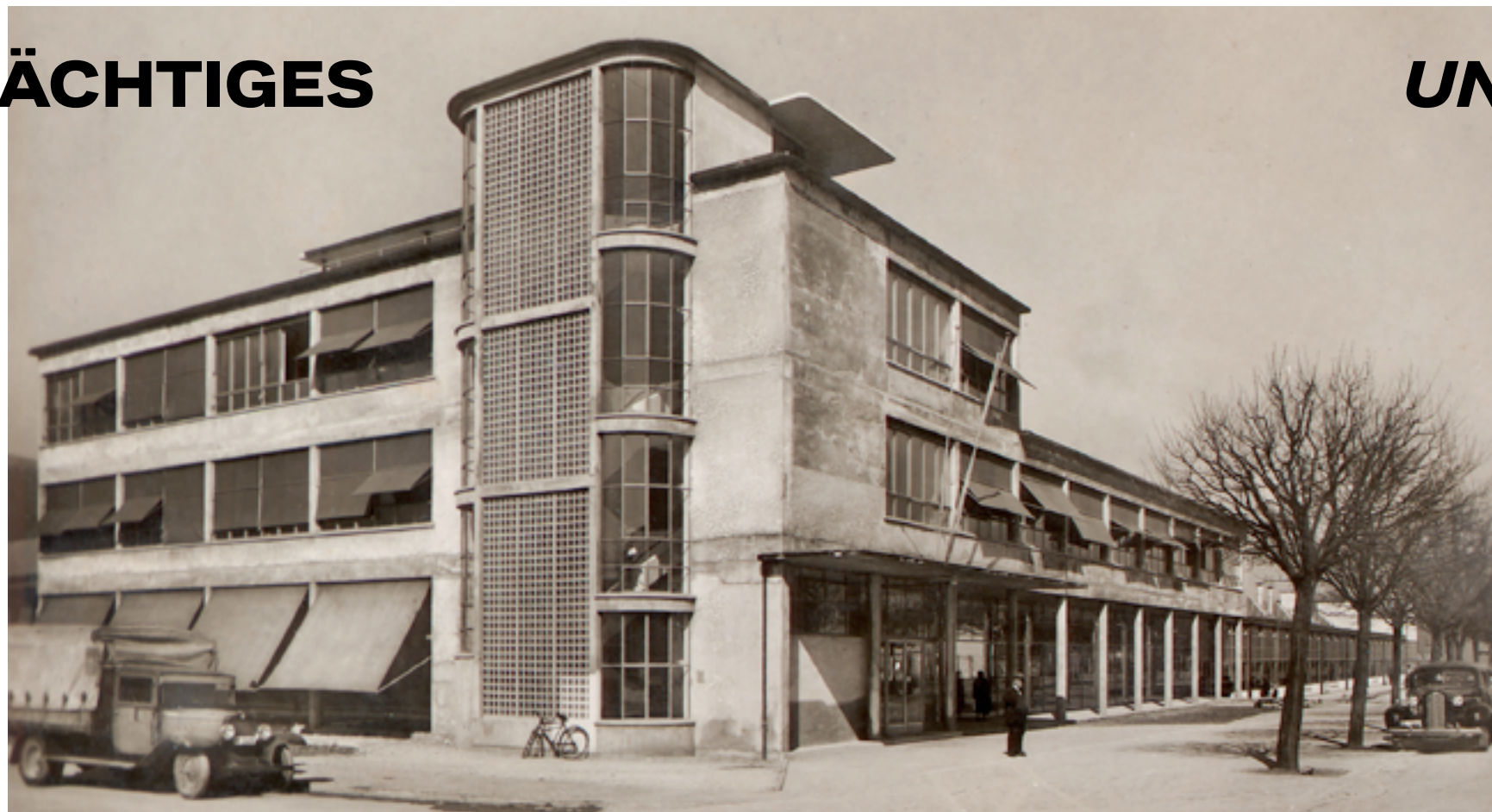
Blick auf das Verwaltungsgebäude und die daran anschliessende Montagehalle. Die Säulenpromenade mit viel Glas ermöglichte Einblicke in die Fertigung.
