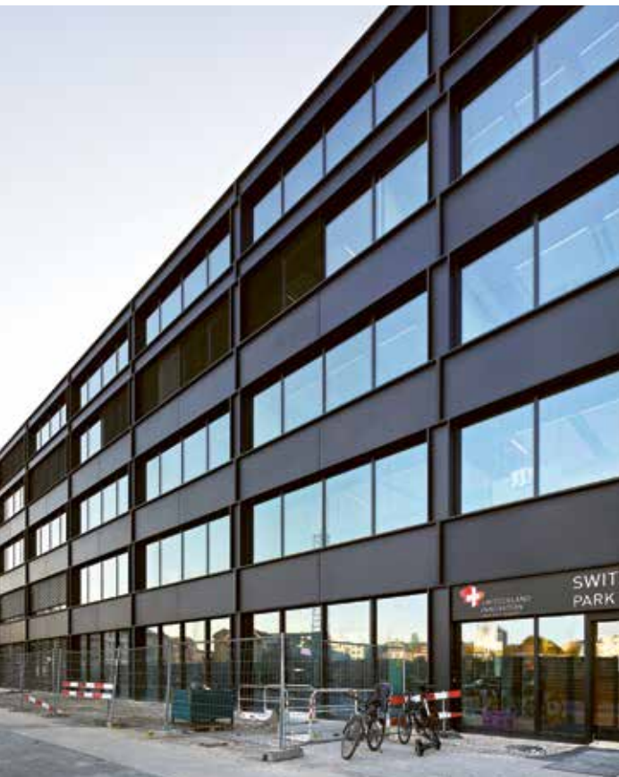
Anspruchsvolle Fassadengestaltung trotz Kostendruck.
