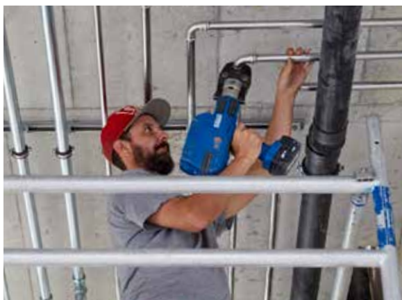
Inox-Wasserleitungen werden im Press-System aufgebaut
