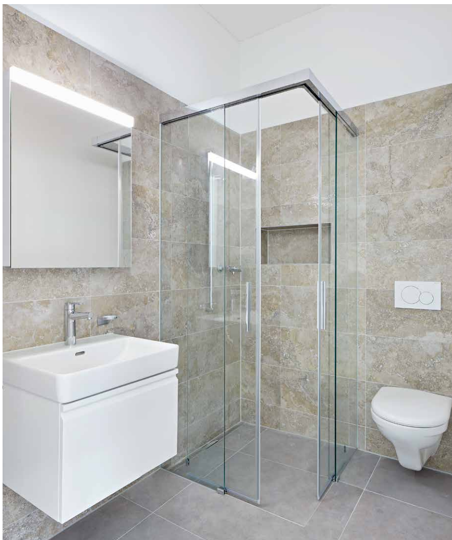
Sanitärarbeiten inklusive Ausstattung der Badezimmer
