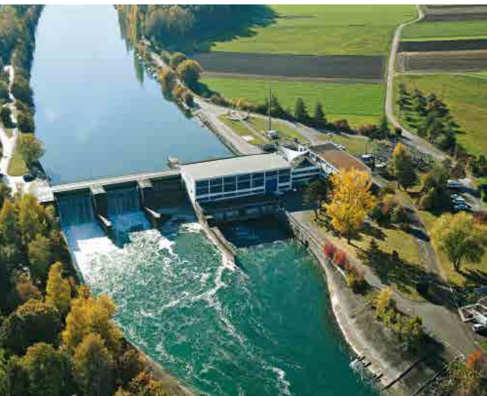
Nachhaltige Stromproduktion: Wasserkraftwerk Aarberg.
